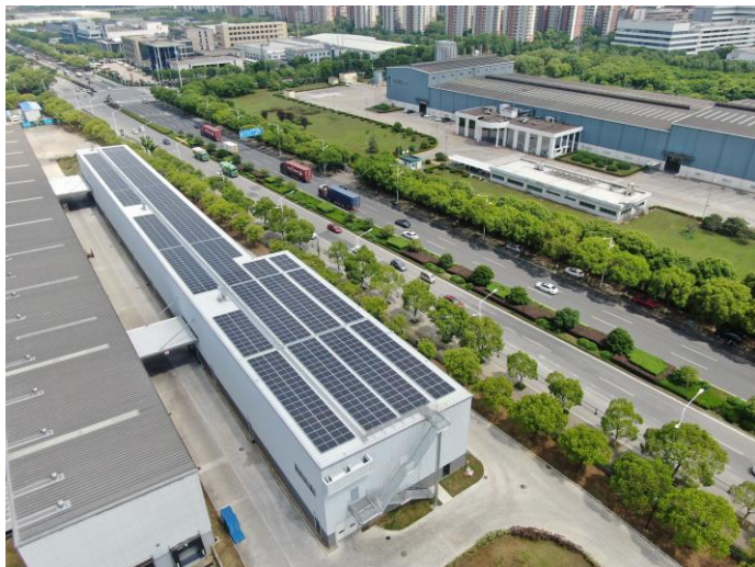
德莎中国在苏州厂区安装光伏发电设施
